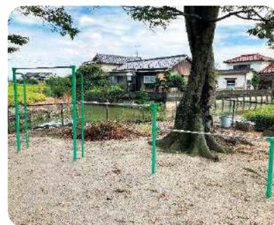
芦刈町 浜中区 砂・鉄棒補修
