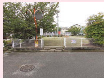
牛津町天満町 フェンスの補修
