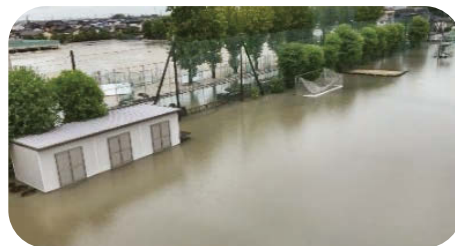
冠水した運動場
