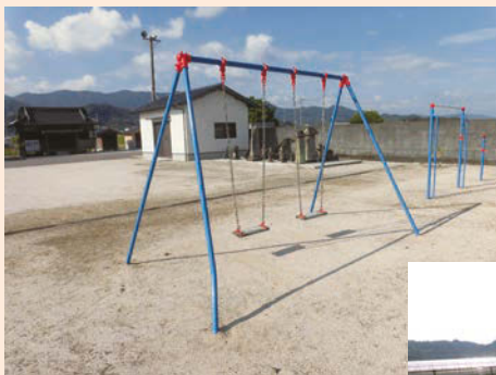
小城町大江 ぶらんこ、鉄棒 すべり台の補修
