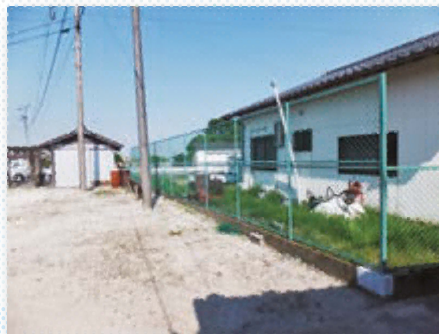
牛津町乙柳 フェンスの新設
