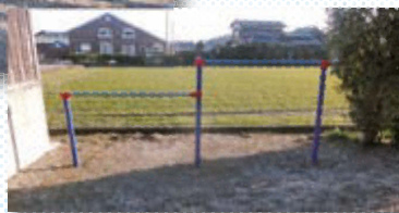
小城市船田 ぶらんこ、すべり台、鉄棒の補修
