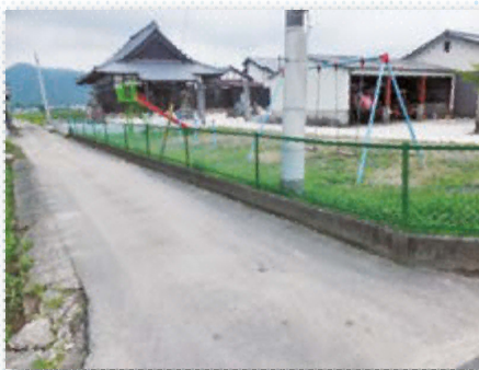
三日月町立物 フェンスの補修
