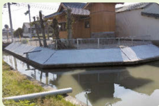
芦刈町中村 フェンス新設
