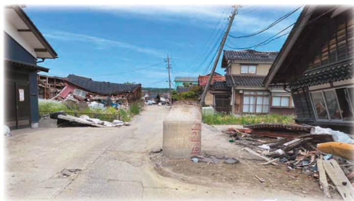
【道路から隆起したマンホール】
