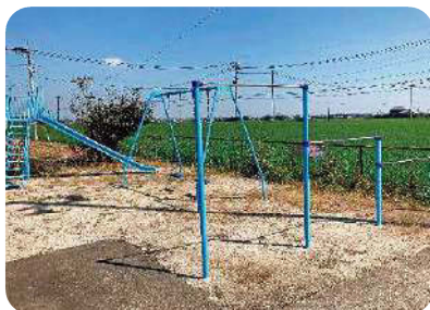
三日月町 吉原区 遊具補修
