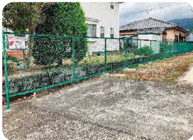
三日月町 長神田区 フェンス新設
