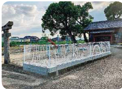
芦刈町 西戸崎区 フェンス新設
